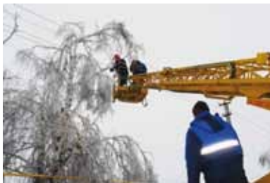
Рис. 2. Обслуживание ВЛ при тяжелых погодных условиях
