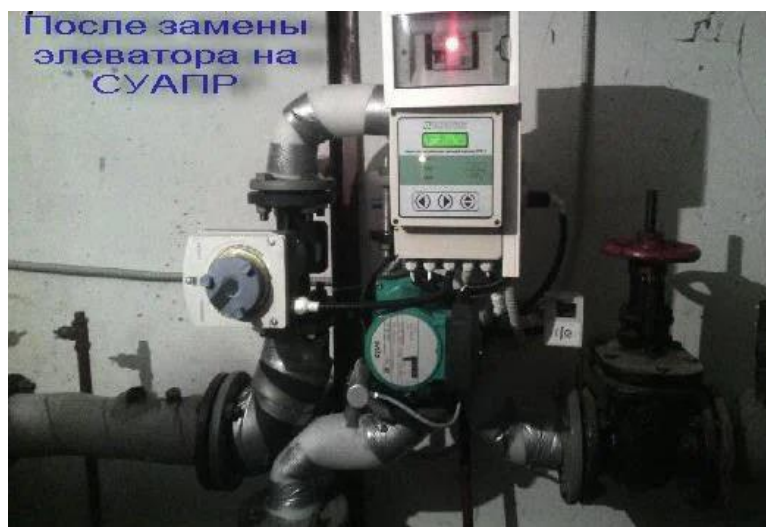
Рис. 4. Замена элеватора на СУАПР
