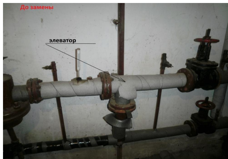
Рис. 3. До модернизации ИТП (с элеватором)
