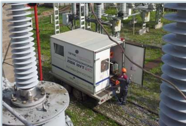
Монтаж, наладка РЗА, АСУТП и АСКУЭ оборудования ПС 110/10/6 кВ «Свердловская» «Центральные электрические сети» «Нижновэнерго», г. Нижний Новгород
