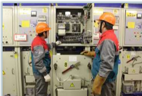
Монтаж, наладка РЗА подстанций 110/35/6(10) кВ, в том числе устройств микропроцессорной защиты
