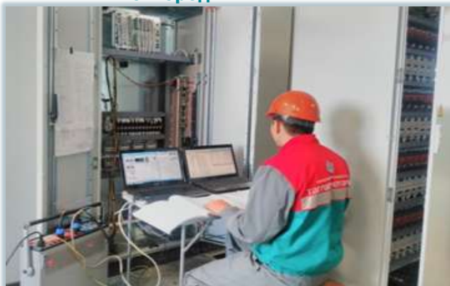
Монтаж и наладка РЗА, АСУТП и АСКУЭ оборудования ПС 220 кВ «Возрождение» для нужд филиала ОАО «ФСК ЕЭС»-МЭС Волги, Саратовская область
