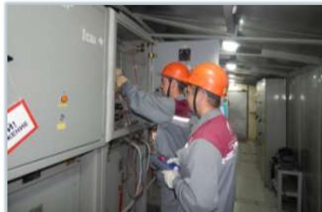
Восстановление работы релейной защиты и автоматики релейных шкафов высоковольтных ячеек а ПС 35/6 Кухтино АО «Белкамнефть» им. А.А. Волкова, г. Ижевск
