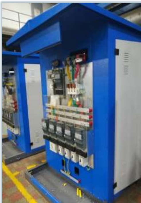
Комплектная трансформаторная подстанция 6 (10) кВ
