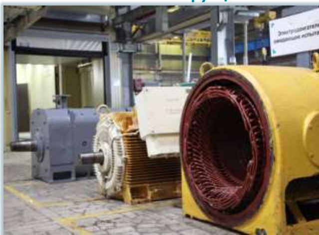
Завод по ремонту электродвигателей и генераторов
