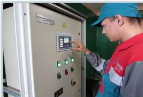
Монтаж, наладка и обслуживание систем телемеханики, станций управления с преобразователем частоты и устройств, плавного пуска АД, систем видеонаблюдения, АСУТП и АСКУЭ
