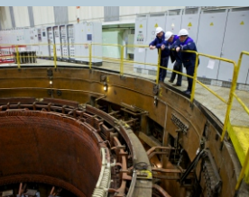
капитальный ремонт гидроагрегата
