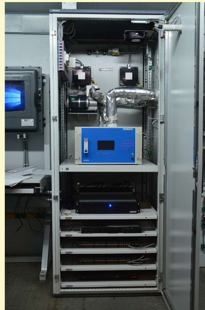
Автоматическая система контроля выбросов в атмосферу MS3550-M3 https://youtu.be/Bku1STDN4pA
