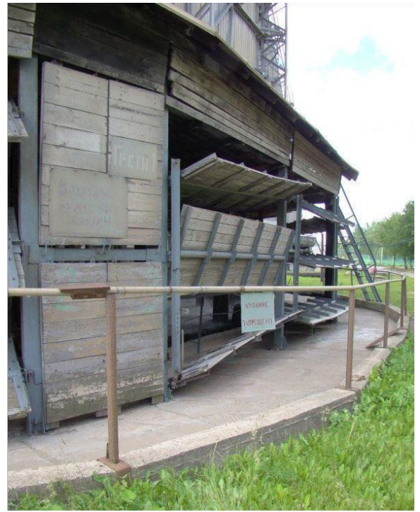
Рисунок 1.18 – Неисправность воздуховодных окон
