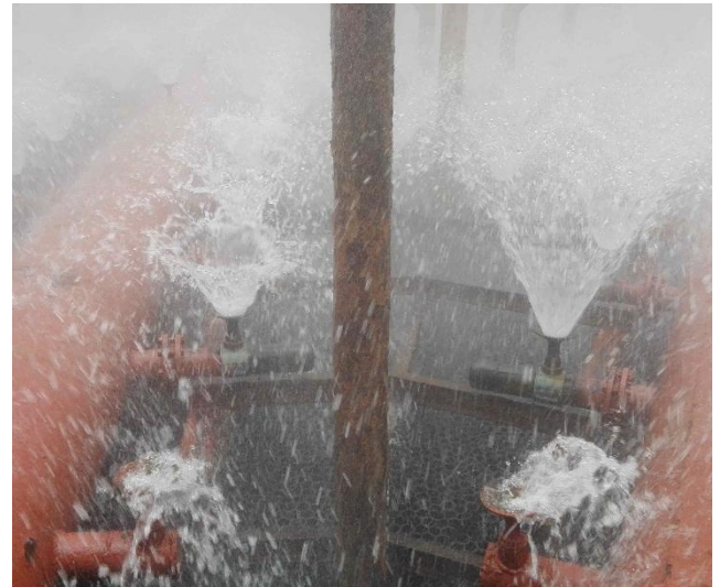
Рисунок А.4 – Поломленные и засоренные сопла
