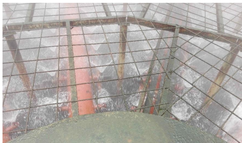
Рисунок А.5 – Биологические обрастания на поверхности ВРС
