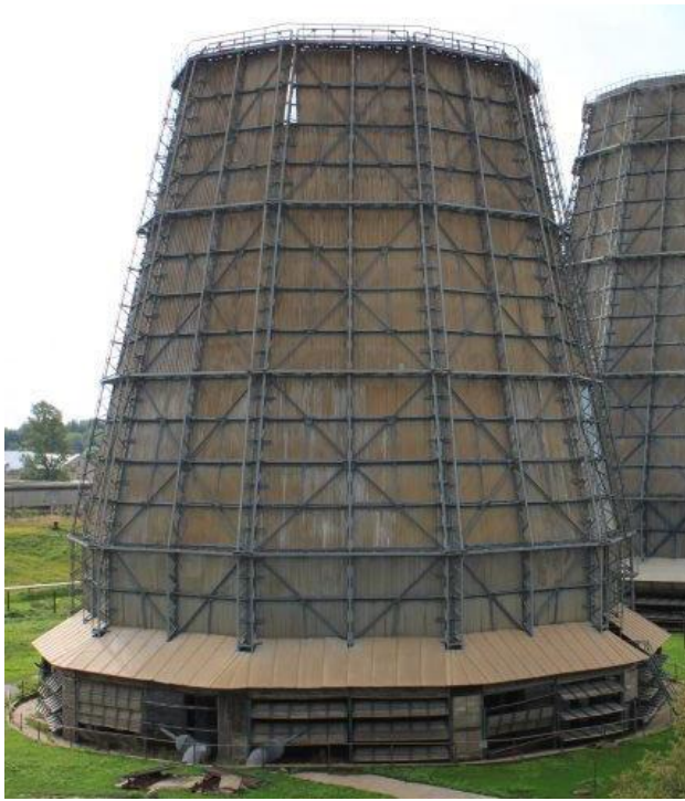
Рисунок 1.17 – Неотрегулированное положение воздуховодных окон
