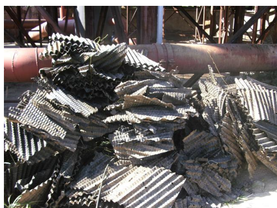
Рисунок 1.13 – Элементы оросителя
