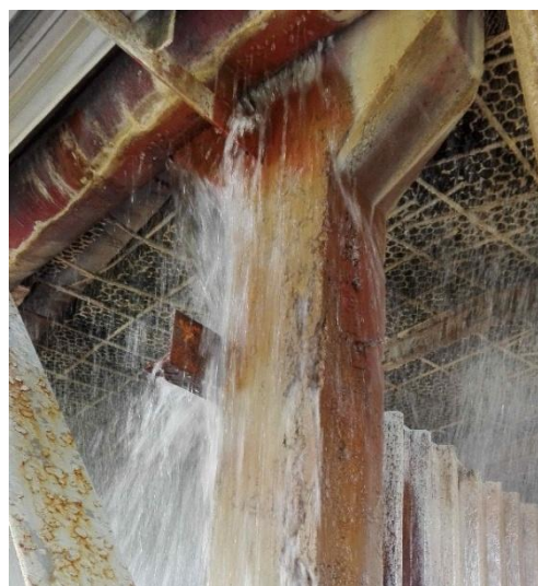
Рисунок А.1 – Биологическое обрастание Рисунок А.2 – Коррозия на каркасе
