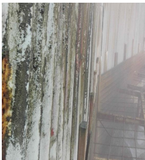
Рисунок А.1 – Биологическое обрастание Рисунок А.2 – Коррозия на каркасе
