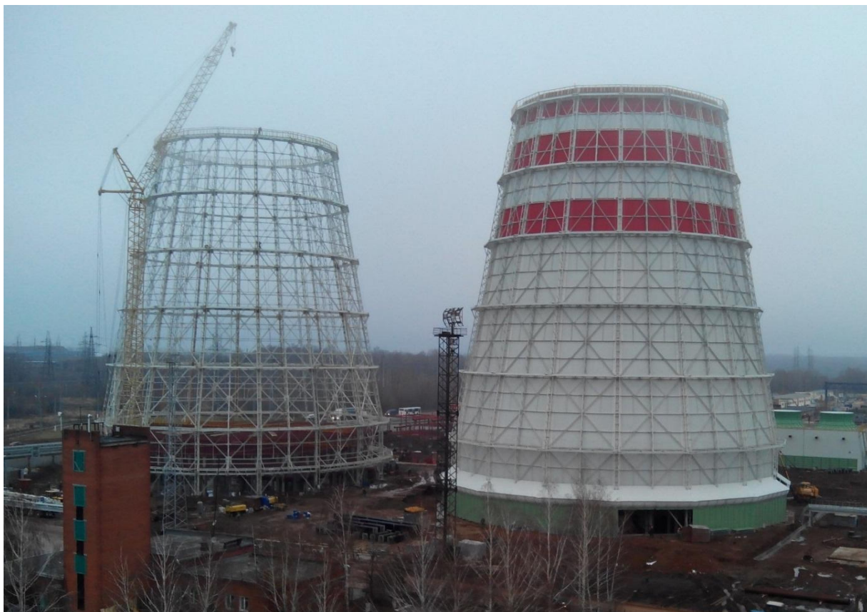
Рисунок 1.3 – Башенные градирни на этапе строительства
