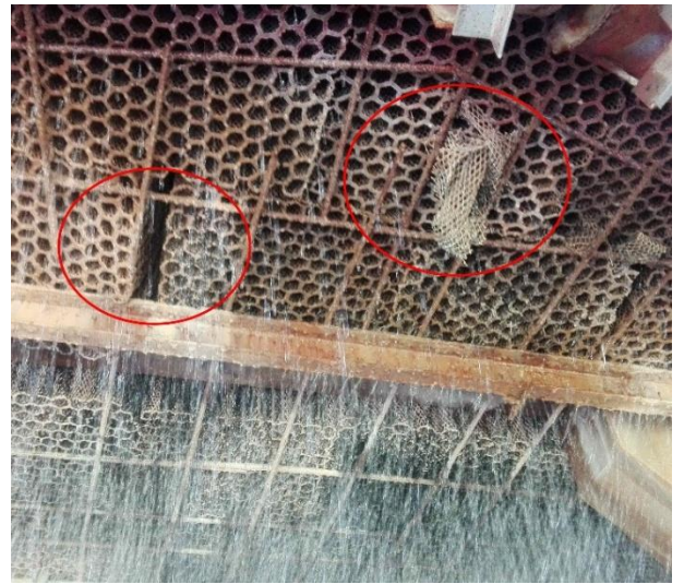
Рисунок А.3 – Дефекты оросительного устройства
