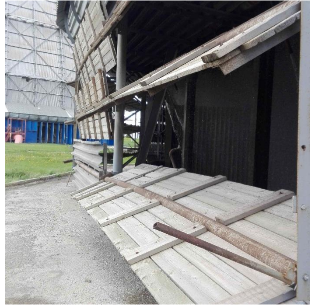
Рисунок А.6 – Разнородное положение воздуховодных окон БГ-2600
