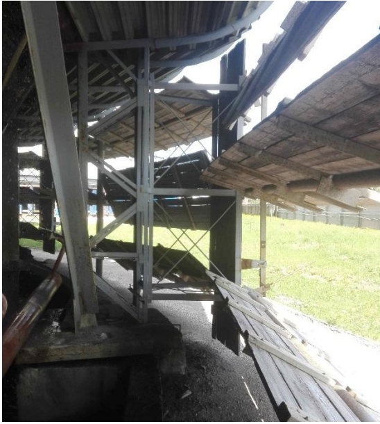
Рисунок А.6 – Разнородное положение воздуховодных окон БГ-2600
