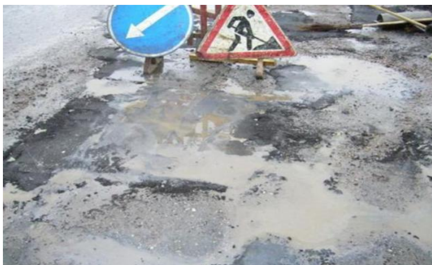
Рис. 2. Локальный текущий ремонт покрытия
