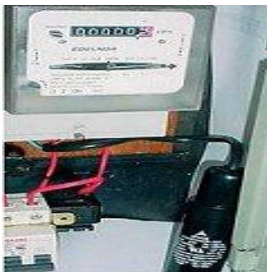
Рис. 4. Ящик учета с установленным конденсатором HomeCap
