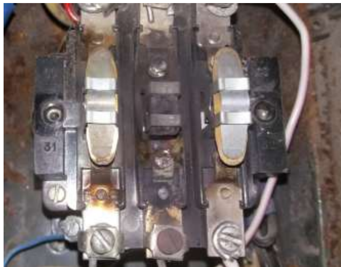
Рисунок 2 – Обгоревшие контакты пускателя
