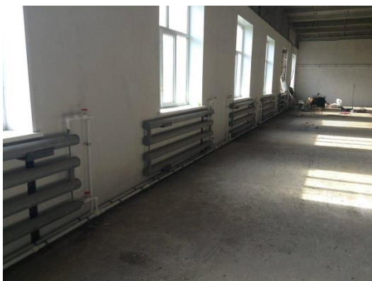
Рисунок 1. Система отопления ремонтно-столярного цеха предприятия.
