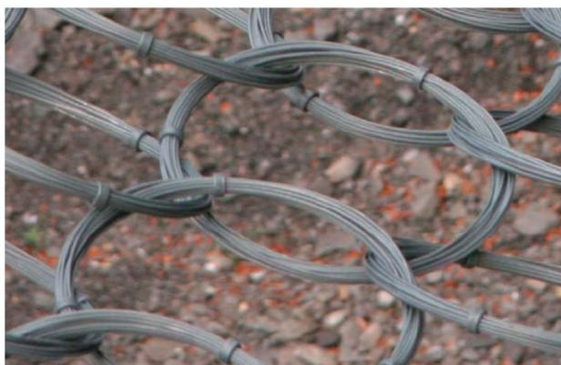
Рисунок 2 – Фрагмент стыковки звеньев высокопрочной стальной сетки
