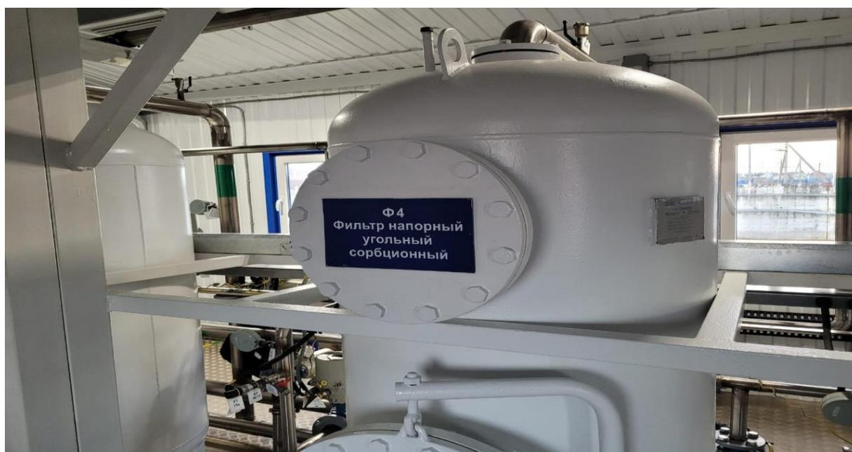
Рис. 1. Фильтр напорный угольный сорбционный
