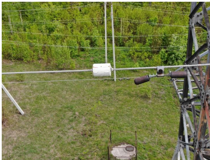
Рис. 2. Новая версия датчика состояния ВЛЭП
