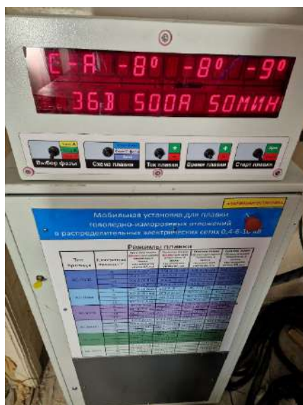
Рис. 2. Панель управления системы мобильной плавки гололеда
