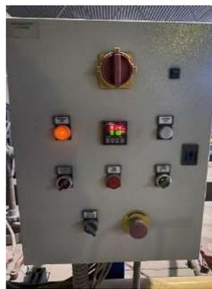
Рис. 3 Шкаф управления горелочными группами
