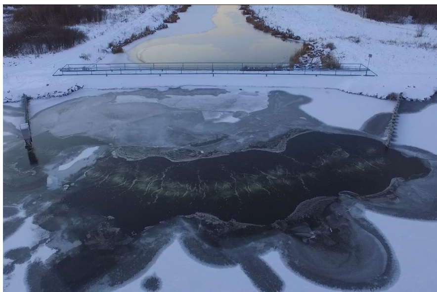
Рис 5. Зона воздействия РЗУ типа «водовоздушная завеса» в Зайнском водохранилище
