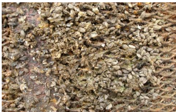
Рис.15. Биологические обрастания на решетке Fig.15. Biological fouling on the grill of the fish рыбозащитного устройства ТЭЦ protection device of a thermal power plant
