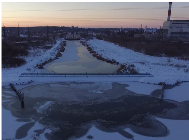
Рис 2. Работа РЗУ типа «водовоздушная завеса» в Заинском водохранилище
