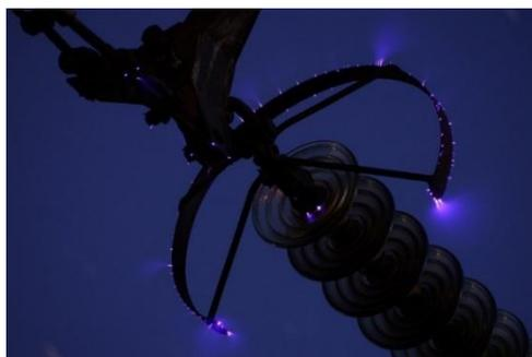
Рис. 1. Коронный разряд на воздушных линиях электропередач
