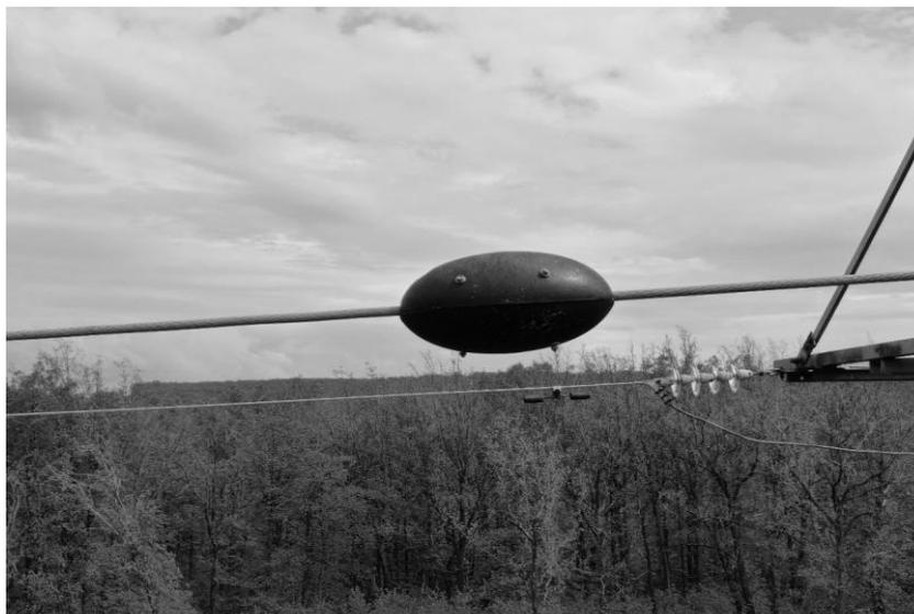
Рис. 1. Датчик анализа состояния ВЛЭП старая версия
