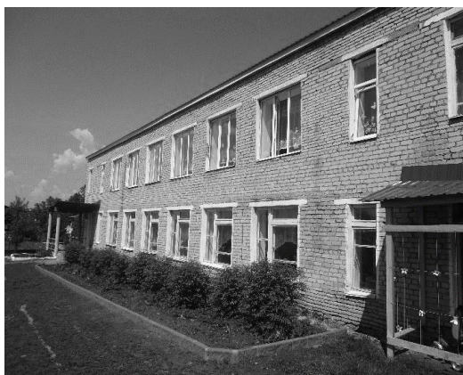
Рисунок 1. Общий вид здания детского сада
