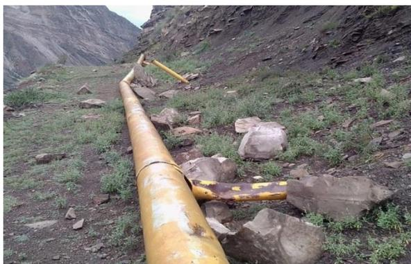
Рисунок 4 - Поврежденный газопровод после камнепада
