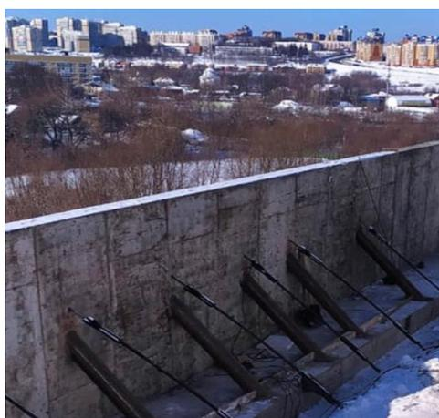
Рисунок 3 – Заглубленные удерживающие железобетонные конструкции с использованием буринъекционных свай ЭРТ (РИТ, ФОРСТ, ЭРСТ), грунтовых анкеров ЭРТ и монолитных железобетонных уголкового подпорных стен в г. Чебоксары
