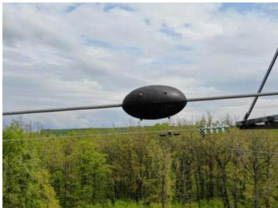
Рис. 1. Датчик состояния ВЛЭП
