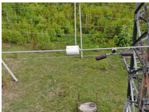
Рис. 2. Новая версия датчик состояния ВЛЭП
