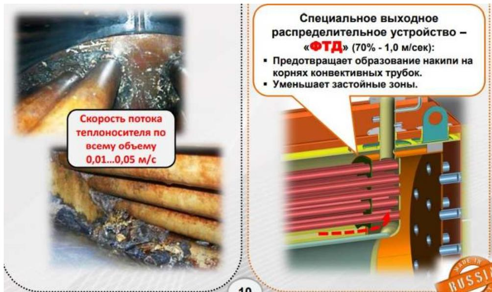
Рис. 1. Установка ФТД в жаротрубном водогрейном котле
