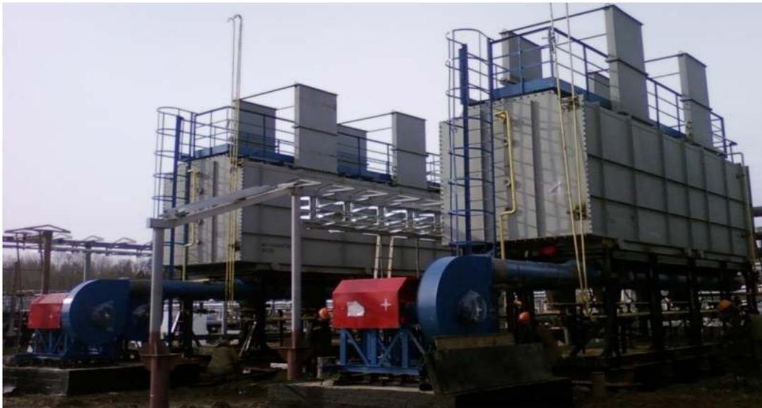
Рис. 1. Печь трубная блочная ПТБ-10А
