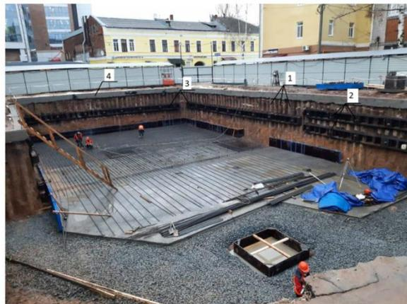
Рис.6. Фрагмент плана ограждения котлована: 1-буриньекционные сваи ЭРТ; 2-грунтовые анкера ЭРТ; 3-анкерный обвязочный пояс; 4-монолитный железобетонный обвязочный пояс.
