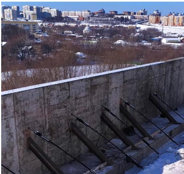
Рисунок 3. Заглубленные удерживающие железобетонные конструкции с использованием буринъекционных свай ЭРТ (РИТ, ФОРСТ, ЭРСТ), грунтовых анкеров ЭРТ и монолитных железобетонных уголковых подпорных стен в г. Чебоксары.
