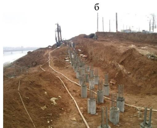
*Ленточное свайное поле из буроинъекционных свай ЭРТ (РИТ, ФОРСТ, ЭРСТ) под монолитную уголкового подпорную стену на Окском съезде в г. Н. Новгород*
