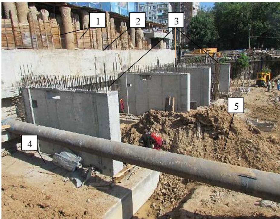
Рисунок 3. Фрагменты выполненных монолитных железобетонных контрфорсов: 1 – существующие буронаблюдательные сваи ограждения котлована; 2 – ограждение котлована из монолитного железобетона; 3 – монолитные железобетонные контрфорсы усиления существующей подпорной стены; 4 – монолитный железобетонный ростверк; 5 – существующая труба – расстрел усиления
