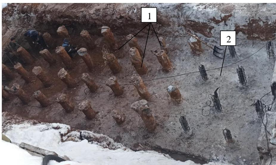
Рисунок 2. Свайное поле под монолитный железобетонный контрфорс: 1 – оголовки буроинъекционных свай ЭРТ; 2 – бетонная подготовка под ростверк.
