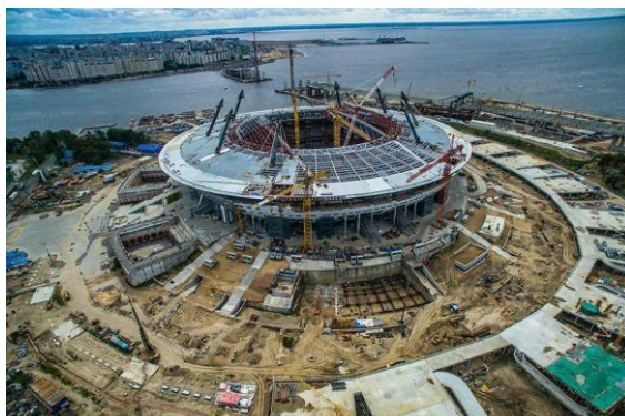
Рис. 1. Каркас стадиона «Зенит Арена» г. Санкт-Петербург
