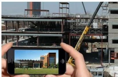
Рис. 2. Применение технологии дополненной реальности на строительном объекте
