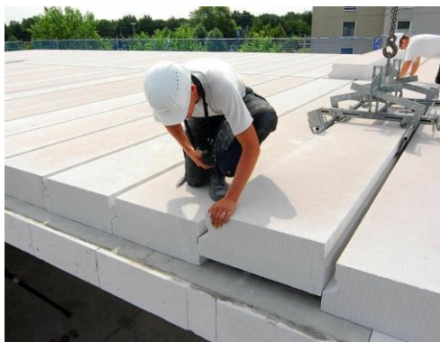
Рис. 1. Перекрытия из пенобетонных плит
