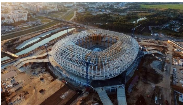
Рис. 2. Каркас стадиона «Мордовия Арена» г. Саранск
