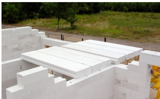
Рис. 2. Перекрытия из пенобетонных панелей
