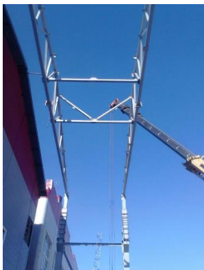
Рис. 5. Вертикальные связи между фермами
