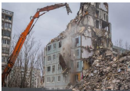
Рис. 1. Снос жилого здания
