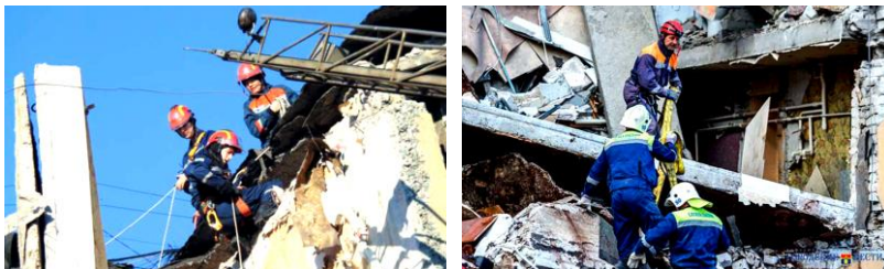
Рис. 1. Использование синтетических строп при разборке завалов
