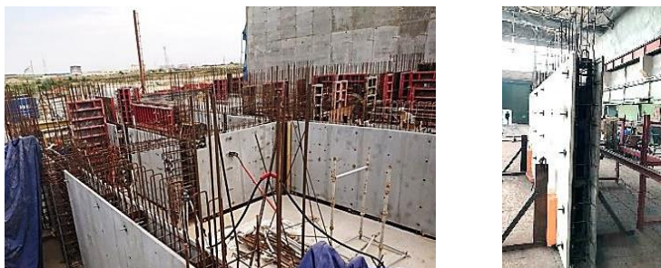
Рис. 1. Использование сталефибробетонных панелей при строительстве Курской АЭС-2
