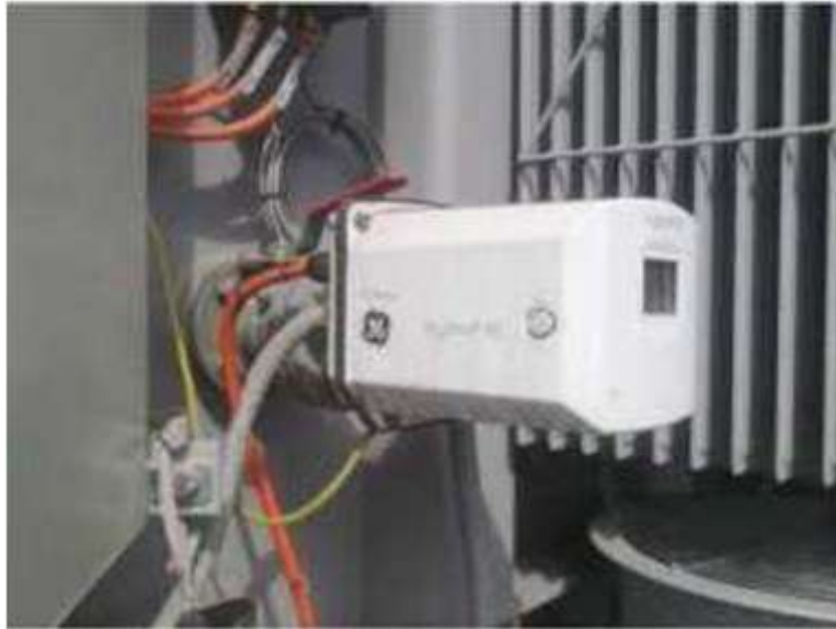
Рис. 5. Подключение анализатора газов Hydran M2
