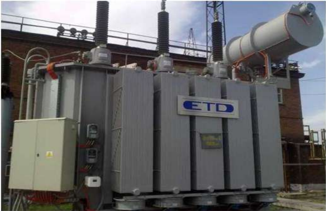
Рис. 4. Установка диагностического оборудования на трансформаторе
