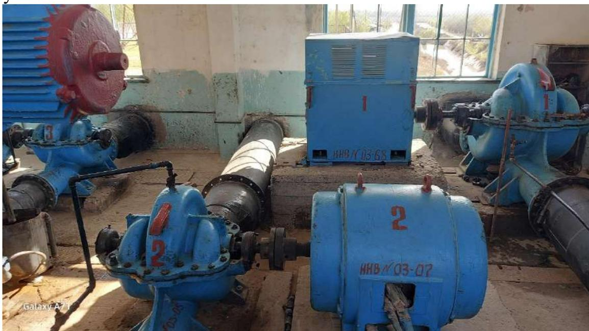
Рисунок 1.4. Внешний вид электродвигателей 1,2, насосной станции Уртабуз-1
