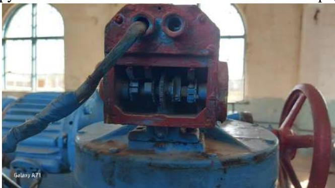
Рисунок 1.8. Внешний вид реле времени автоматики открытия и закрытия затвора
