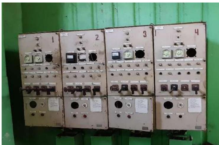
Рисунок 1.9. Пульт управления синхронных двигателей насосной станции
