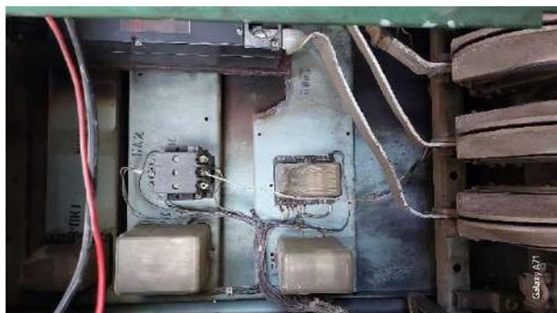
Рисунок 1.7. а) Защита электродвигателя от перегрузки
