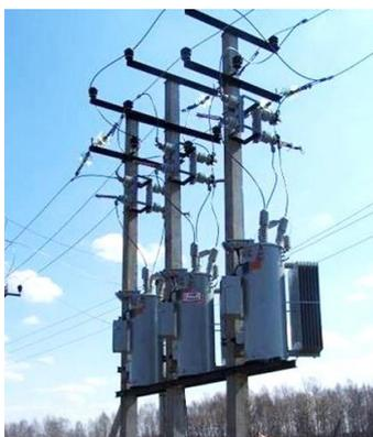
Рисунок 1 – ПАРН на опоре ЛЭП
