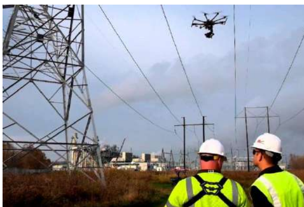
Инженерно-технический персонал наблюдает за применением мультикоптерного БПЛА в ходе плановой диагностики ВЛ с использованием аэросъемки
