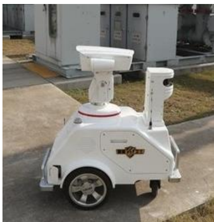
Рис.2. Колесный робот на электрической подстанции
