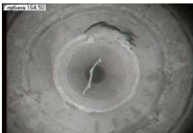
Рис. 1. Повреждение колонны
