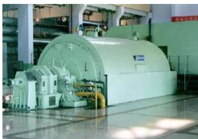
Рис. 1. Турбогенератор типа ТВФ-110
