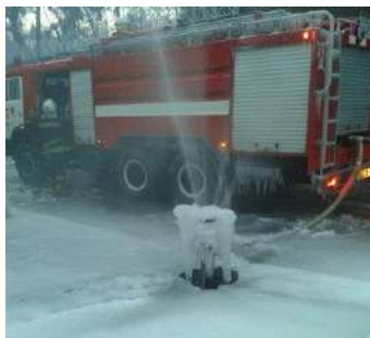
Рис. 1. Вид источника пожарного водоснабжения
