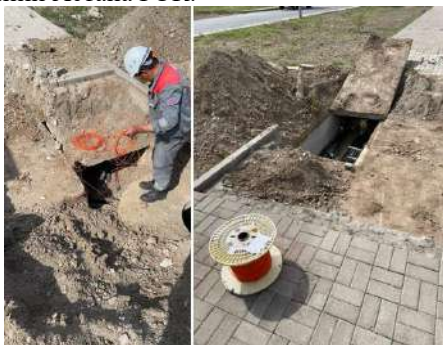
Рис. 7. Монтаж волоконно-оптических датчиков Fig. 7. Installation of fiber optic sensors
