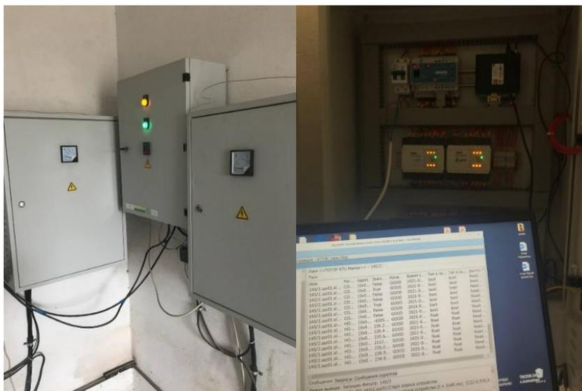
Рис. 4. Экспериментальная установка системы гибкой компенсации реактивной мощности на ТП-701/5
