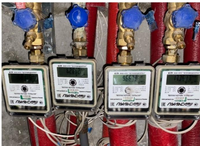
Рис. 1. Автоматизированная система учета тепловой энергии в распределительных коллекторах
