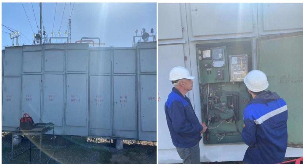
Рис. 2. Ячейка КРН-IV отходящей линий 10 кВ
