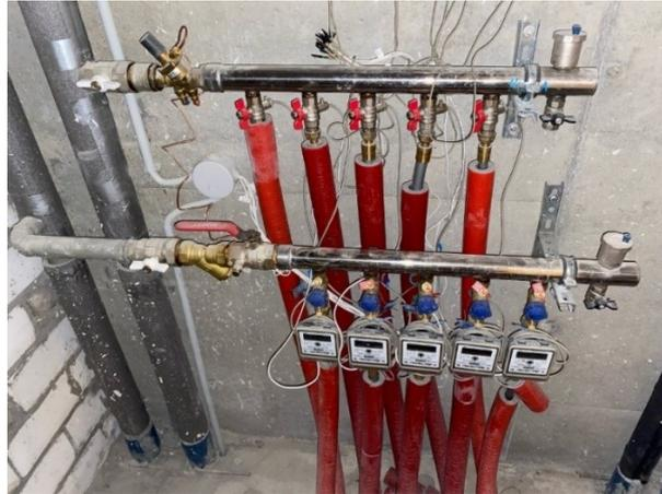
Рис. 3. Распределительный коллектор горизонтальной лучевой системы отопления, установленный в техническом помещении этажа многоквартирного жилого дома
