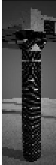
**Рис. 3 – Усиление колонны углеволокном**
