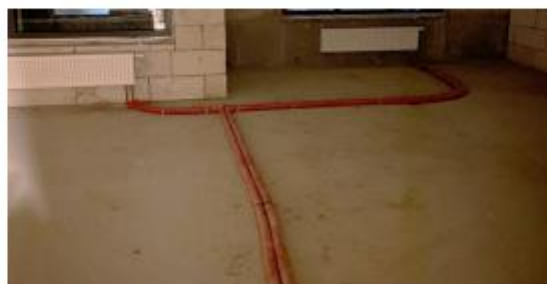
Рис. 4. Монтаж горизонтальной лучевой системы отопления в помещениях многоквартирного жилого дома
