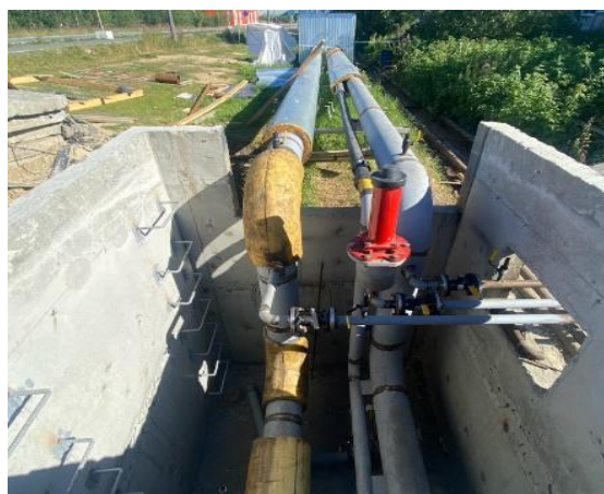
Рис. 1. Совместная прокладка водопровода и тепловых сетей
