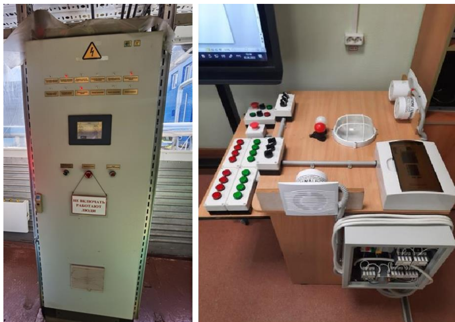
Рис 1. Шкаф системы (слева) и разработанная установка управления газомазутного котла (справа)
