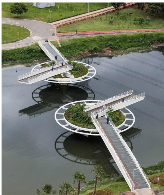
Рис. 1. мост Фридриха Байера в Сан-Паулу
