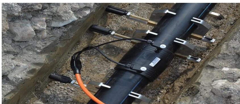
Рис. 3. Электромуфтовая сварка полиэтиленовых труб
