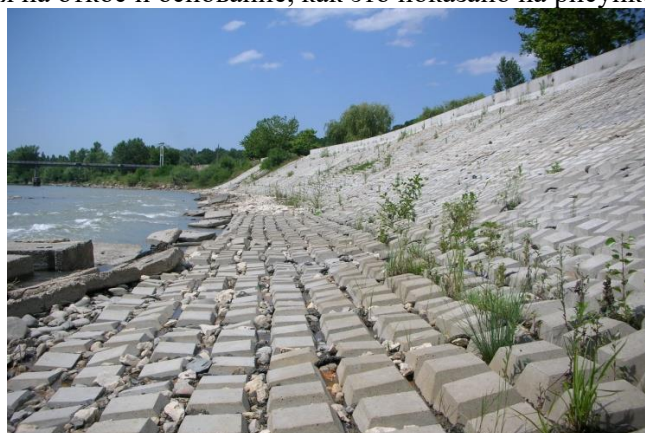
Рисунок 3 – Укладка фартука в период низкого меженного уровня воды при отсутствии волнового воздействия на откос и основание
