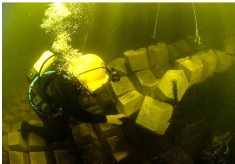
Рисунок 4 – Подводная укладка фартука гибкого бетонного покрытия
