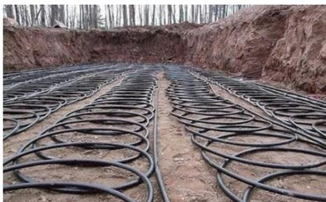
Рис. 3 Горизонтальный геотермальный контур, уложенный спиралями
