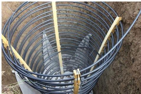
Рис. 4 Вертикальный геотермальный контур
