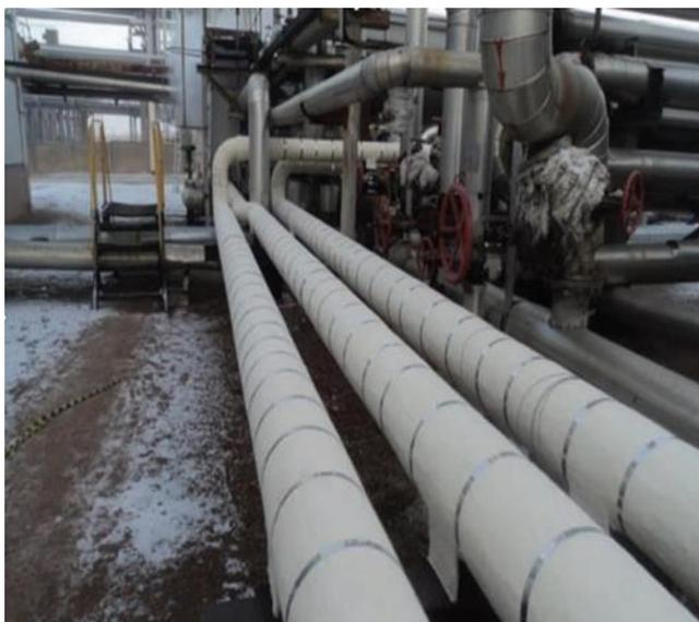
Рис. 4. Теплоизоляционный материал из аэрогеля
