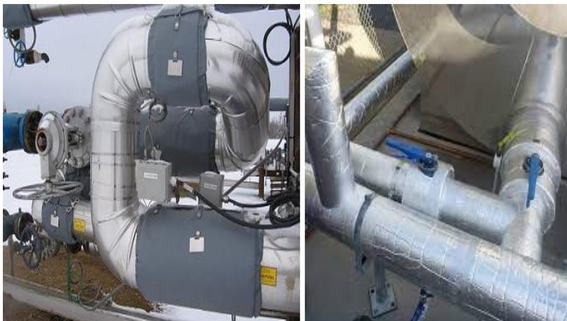
Рис. 2 Изоляция труб на открытом воздухе и в помещении
