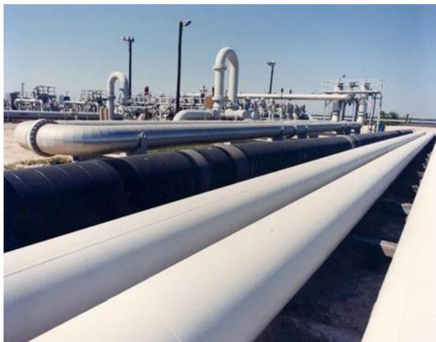
Рис. 2 Теплоизоляционный материал ЖТП
