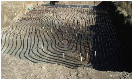
Рис. 2 Горизонтальный геотермальный контур
