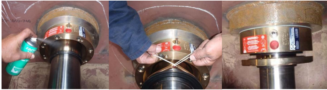
Рисунок 1 – обслуживание дейдвудного уплотнения
