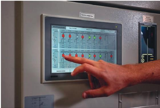
Рис. 1. Процесс мониторинга комплектного распределительного устройства типа КРУ «Каскад»
