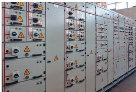
**Рис. 1. Общий вид модульного НКУ трансформаторной подстанции**
