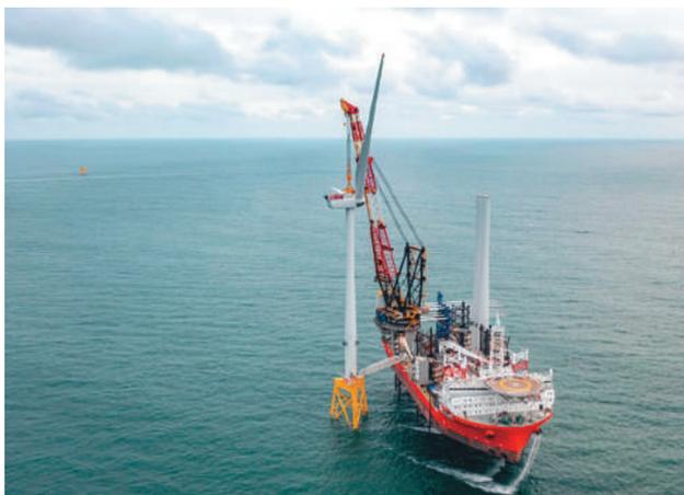
Рис. 1. Агрегат ВЭС Vestas V164-10 MW
