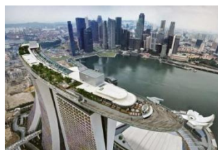
Рисунок 8 — Эксплуатируемая кровля курортного комплекса, состоящего из трех зданий
