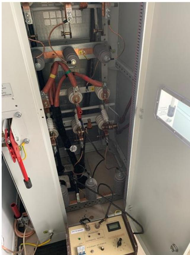
Рис .7. Подключение генератора звуковых частот к кабелю ААБл-10 3х95
