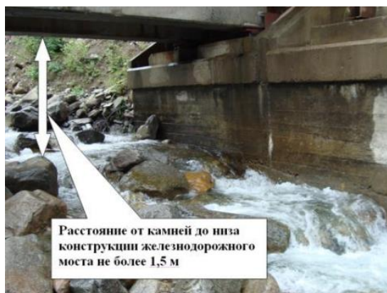
Рисунок 2 – Вид западного устоя и части подмостового русла железнодорожного моста через ручей Вредный
