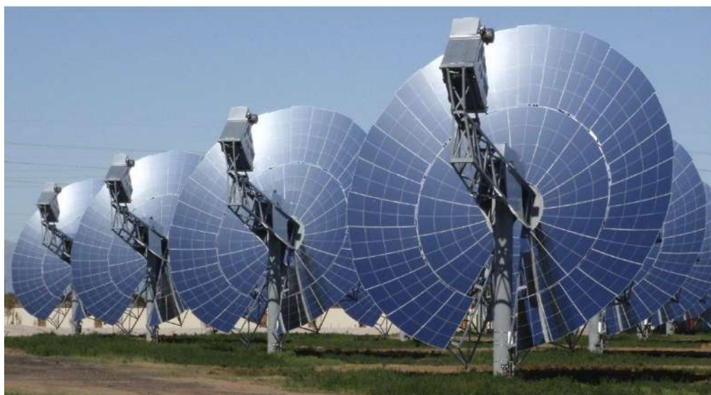
Внешний вид солнечных электростанций с двигателями Стирлинга
