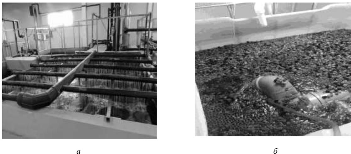
Рис. 4. Биологические фильтры установок с замкнутым циклом водоснабжения:
