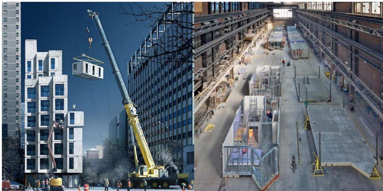
**Рис. 1. Объемная модульная система**
