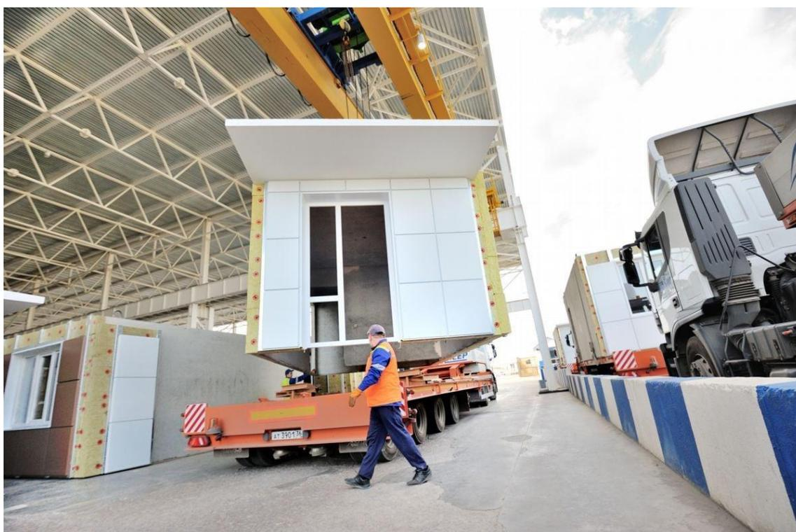
Рис. 4. Изготовление модульных конструкций
