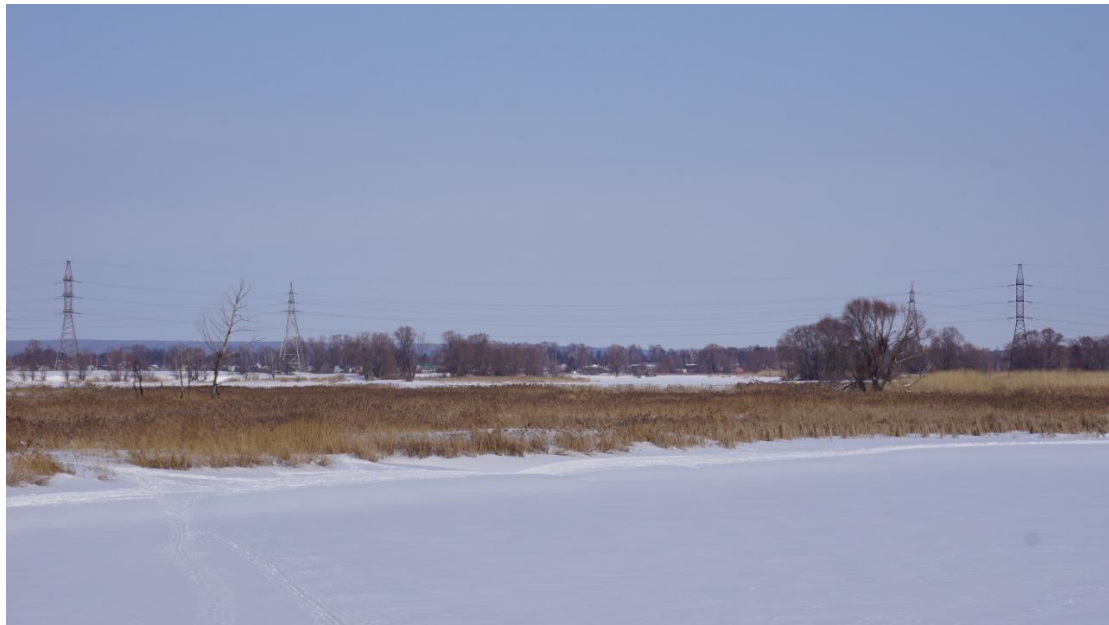
Рис. 2. Фотография пролета с опорами, дата 05.03.2021.
