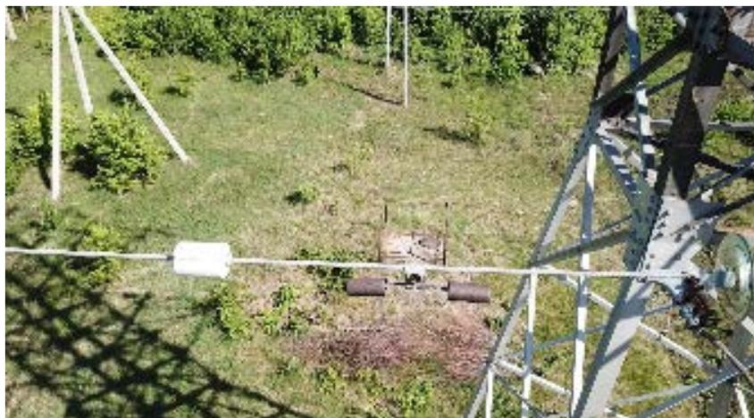
Рис. 2. Устройство контроля для системы мониторинга состояния ЛЭП СМГ-16, установленное на ЛЭП 35 кВ в ПАО «Татнефть».
