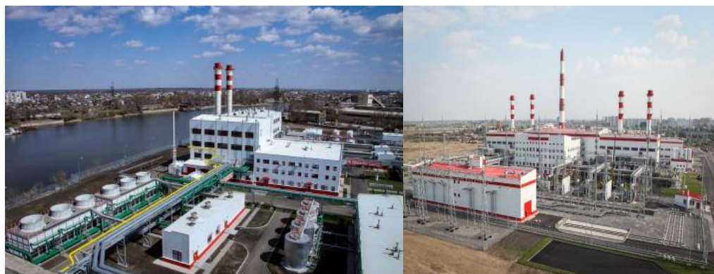
Рис. 5,6. Астраханские ГРЭС ПГУ-110 и ГРЭС ПГУ-235 «Лукойл-Астраханьэнерго» системой ТИАС для охлаждения воздуха на всасе в компрессор турбины
