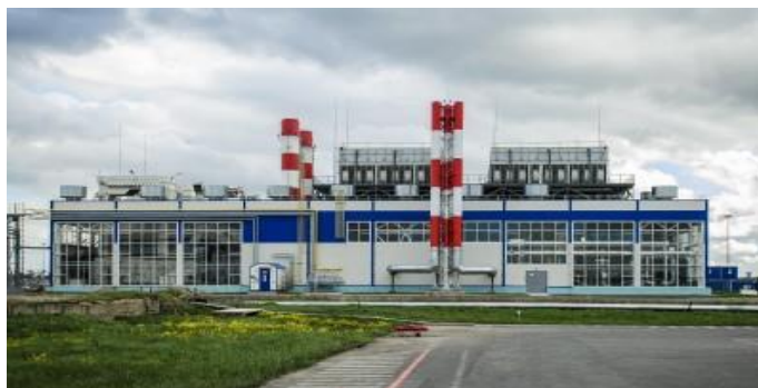
Рис. 9. Энергоцентраэропорта «Пулково», г. Санкт-Петербург
