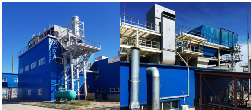
Рис.7.Общий видустановленнойАБХМфирмы "Thermax"
