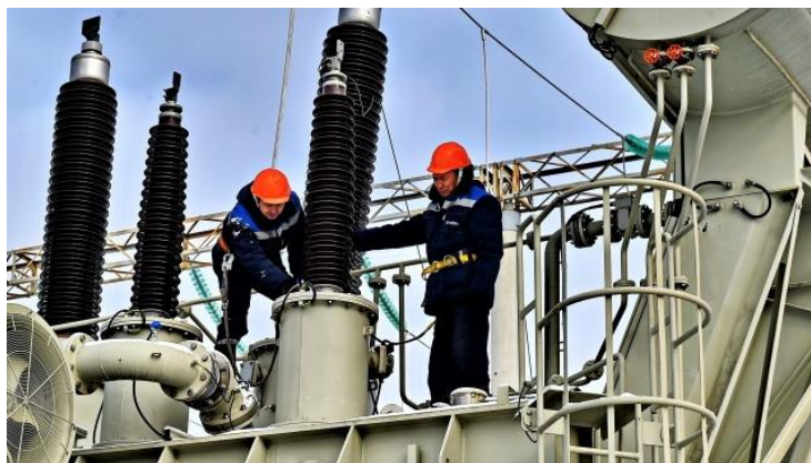
Рис. 2. Монтажные работы на силовом трансформаторе
