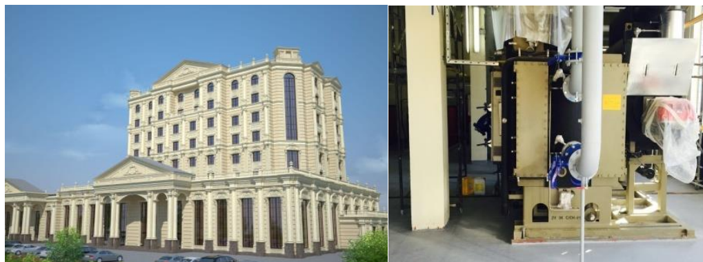
Рис. 10,11. Общий вид отеля и фото АБХМ
