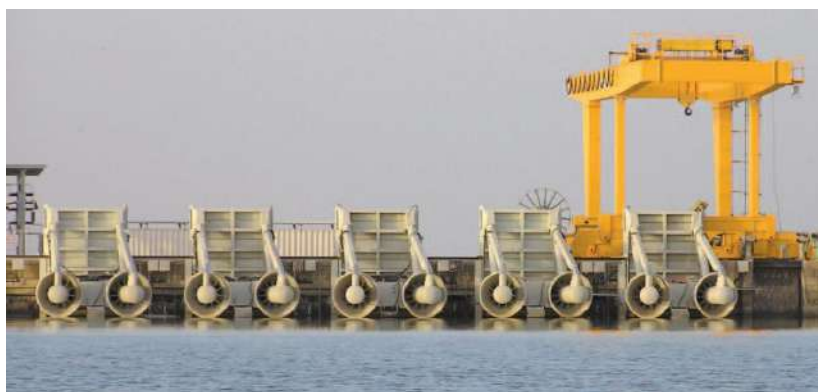
Рис. 3. Матрица мини-ГЭС HYDROMATRIX
