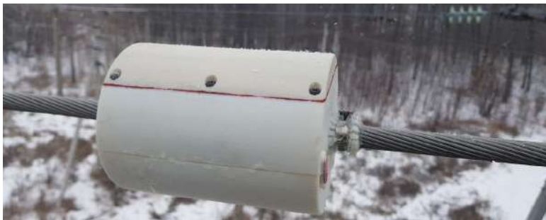
Устройство контроля системы мониторинга ВЛЭП
