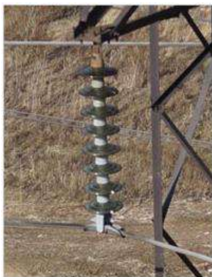
Рис. 1. Изолятор опоры ЛЭП, полученный с помощью Геоскан 401
